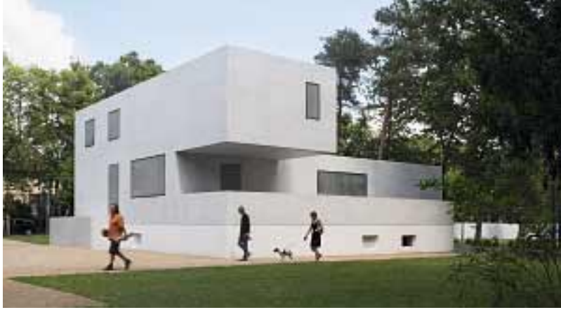
Die Südwestecke von Haus Gropius. Der skulpturale Eindruck entsteht durch den Verzicht auf alle Details und die flächenbündigen transluzenten Glasscheiben. | The southwest corner of the Gropius House: the elimination of details and the flush-mounted, translucent glass windows lend it a sculptural appearance.
