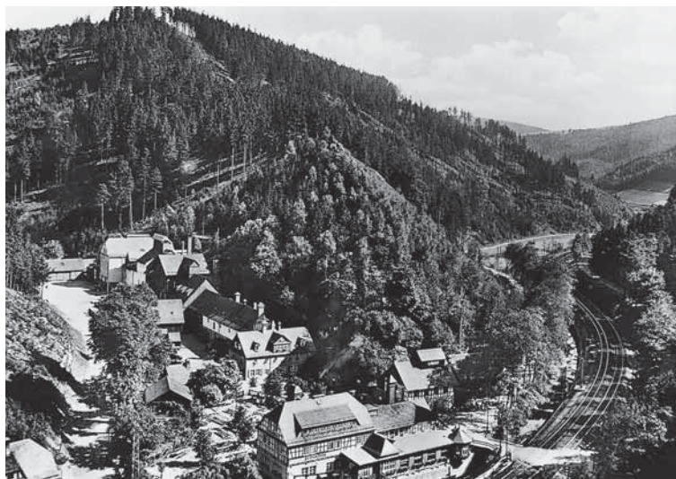
Am Gasthaus »Falkenstein«, das genau auf der Grenze zwischen der amerikanischen und der sowjetischen Zone liegt, regulieren die dort stationierten Soldaten beider Mächte die Grenze auf eigene Faust: Zu Bayern kommt der komplette Wirtshausbetrieb, zu Thüringen dafür ein Stück der Straße.
