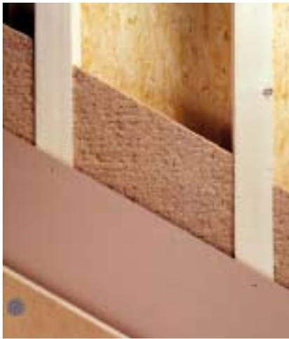
**Oben** Beispiel für einen Holztafel-Wandaufbau, hier mit hochwertiger Holzfaserdämmung (Baukunst Philipphaus).
