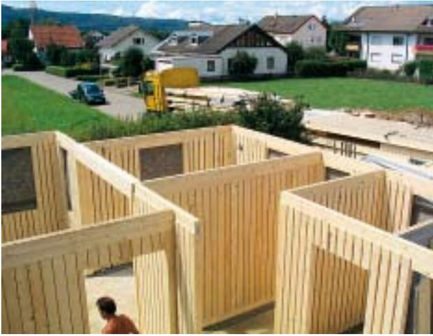
Wünschen des Kunden gefertigt. Computergesteuert und millimetergenau werden großformatige Wand- und Deckenelemente ausgeschnitten, Tür- und Fensteröffnungen eingefügt. Außenwände, die über bis zu vier Geschosse durchlaufen, können auf diese Weise hergestellt werden. Auf dem Bauplatz werden die angelieferten Holzplatten wie ein übergroßes Modelleisenbahn-Häuschen zusammengesetzt.
