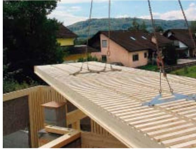
Ein Beispiel für eine moderne Holzbauweise: das System der Firma Lignotrend; links die Wände des Erdgeschosses, rechts das Auflegen einer Zwischendecke
