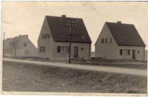
Häuser in einer ehemaligen Werksiedlung in Grevembroich – rechts ist das ab S. 76 im heutigen Zustand dargestellte Haus zu sehen.
